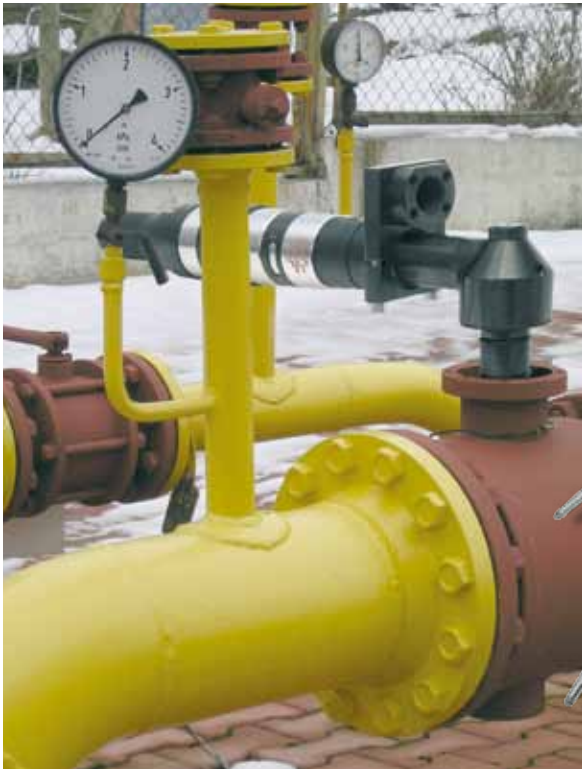
Nuestros motores tipo ,calado' pueden ser utilizados para apertura y cierre de válvulas industriales
